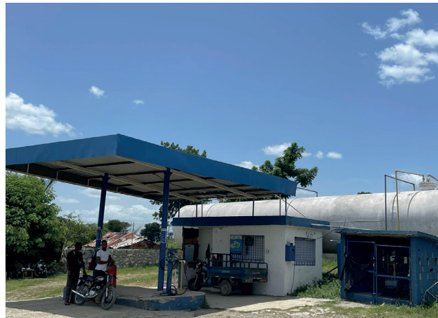
Estación de gas propano Rafa Gas, ubicada en el sector de Villa Hortencia.
