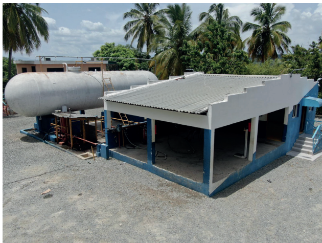
Estación de gas Santa Teresa ubicada en la Carretera Sánchez, Km 2 en la entrada a Elías Piña
